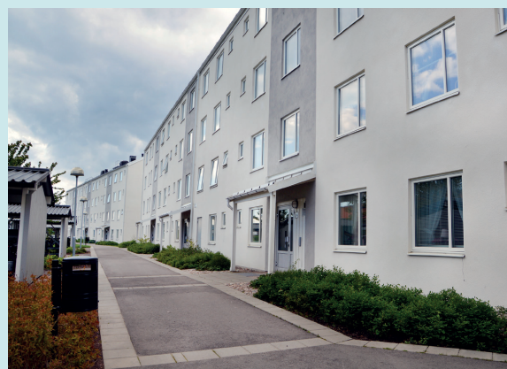
Entrédörrarna på Jacobs gränd ska bytas ut.
