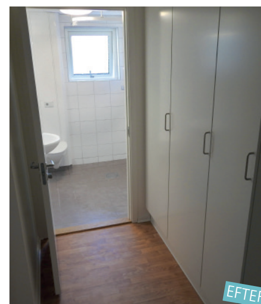
Hall efter stambytet med nya garderober och en bredare ingång till toaletten.
